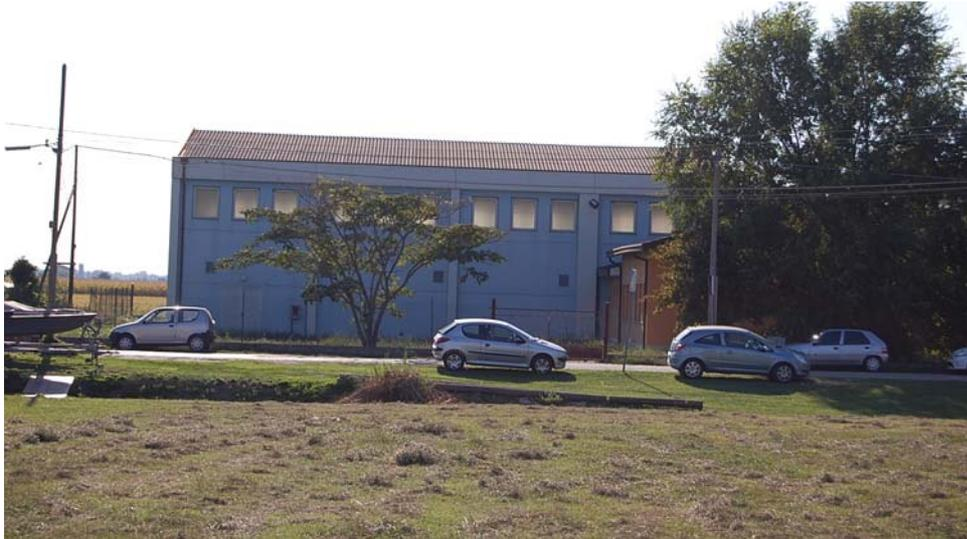
Nel febbraio 2009, l'Ufficio Tecnico ha incaricato il laboratorio di analisi LA.RI.AN di eseguire la valutazione del rischio amianto. Dall'elaborato prodotto emerge un giudizio negativo in ordine allo stato di degrado con la necessità di effettuare **un intervento di manutenzione e bonifica del manto di copertura.**
